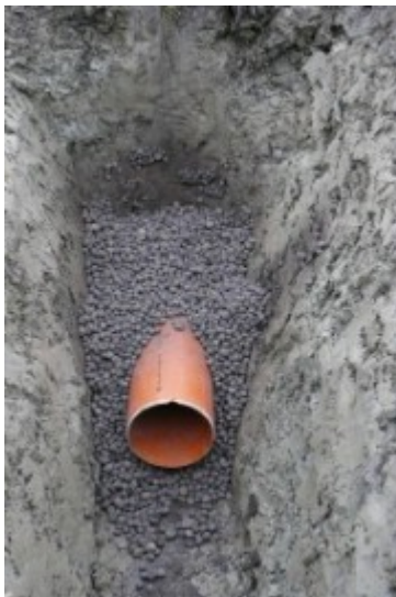
Izolacja termiczna rurociągu za pomocą keramzytu
